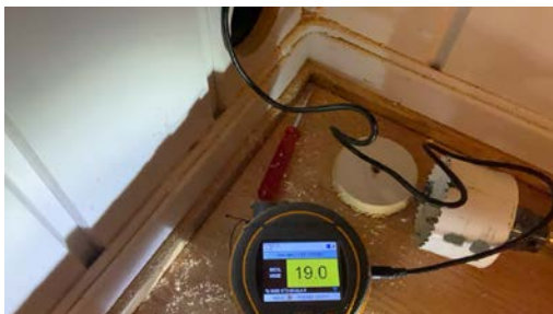
Fuktmåling i konstruksjon mot bad/vaskerom.
