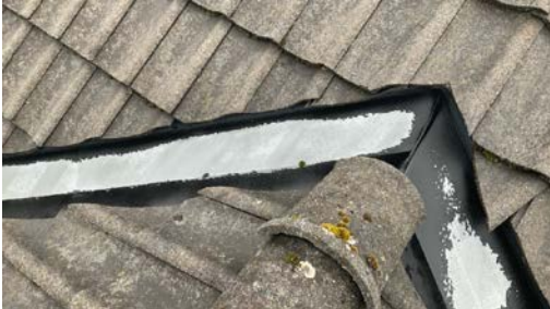
Overflatebehandling i gradrenner flasser.
