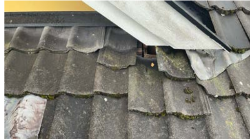
Utett løsning på tak mot tilbygg.
