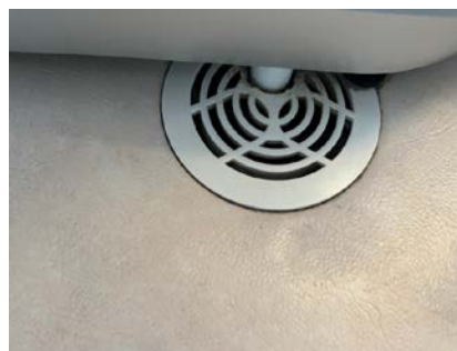
Belegg klemt i sluk
