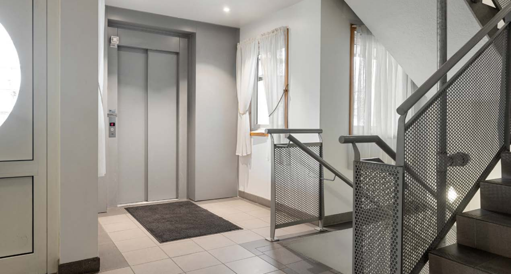
Felles trappegang i bygget.
