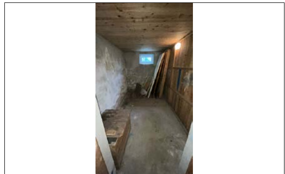
Bod tilhørende enheten i kjeller.
