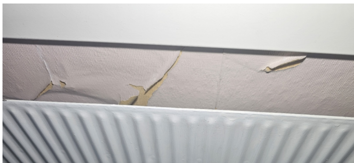
Vegg under vindu på soverom.
