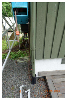
Taknedløp tilordnet til drenering i bakke.
