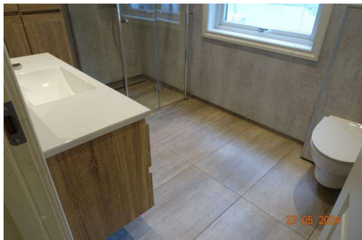
Gulv tildekket med flis.
