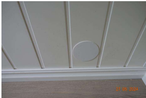
Deksel etter hulltaking i vegg mot bad.
