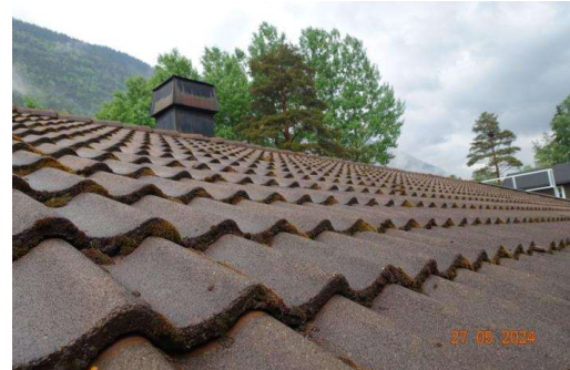
Taktekking av taksteiner.
