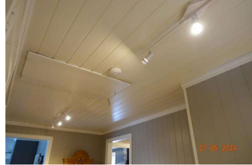
Røykvarsler montert i takhimling.
