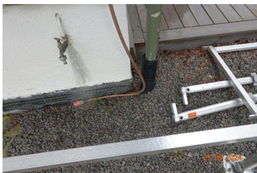
Viser drenering av grunnmur.
