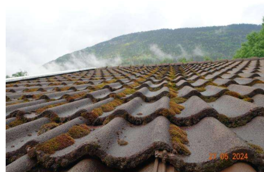
Taktekking av taksteiner.
