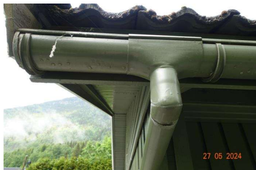
Takrenne med blikk.
