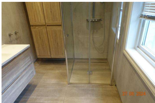
Gulv tildekket med flis.
