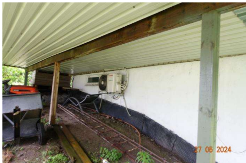
Viser drenering av grunnmur.
