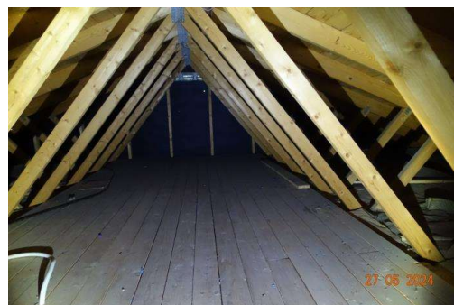
Selvberende takkonstruksjon med undertak.
