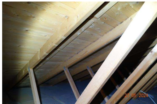
Selvbærende takkonstruksjon med undertak.
