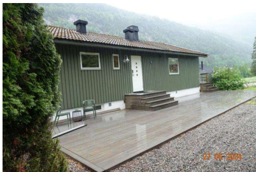
Platting foran hovedinngangen.
