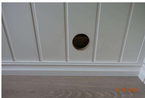
Hulltaking i vegg mot bad.
