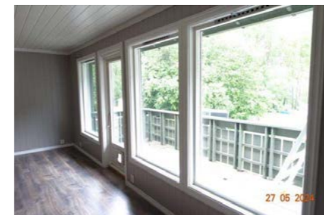
H-vinduer med 3-lags glass.
