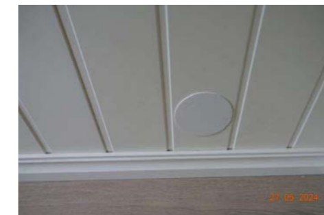
Deksel etter hulltaking i vegg mot bad.
