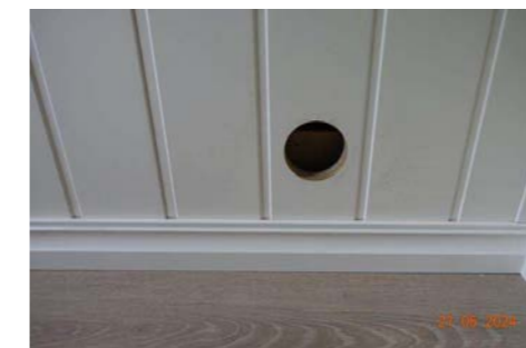
Hulltaking i vegg mot bad.
