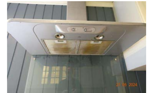
Vegghengt ventilator.
