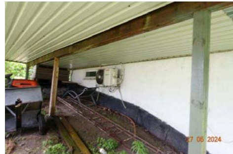
Viser drenering av grunnmur.
