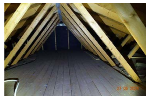
Selvbærende takkonstruksjon med undertak.
