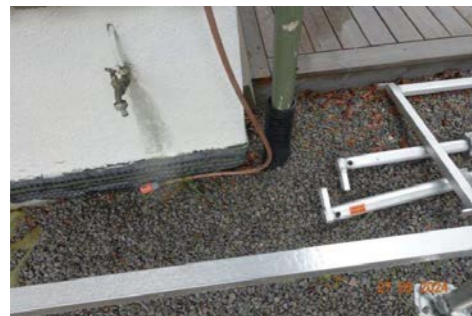
Viser drenering av grunnmur.
