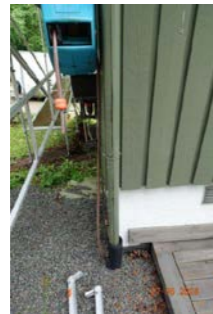
Taknedløp tilordnet til drenering i bakke.
