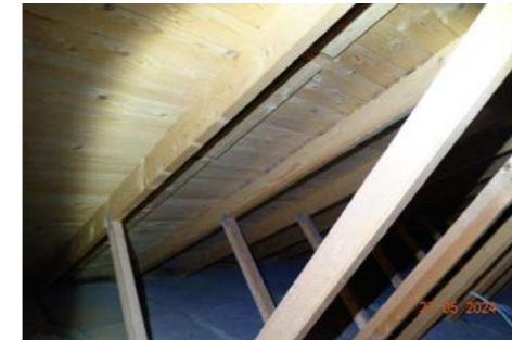
Selvbærende takkonstruksjon med undertak.
