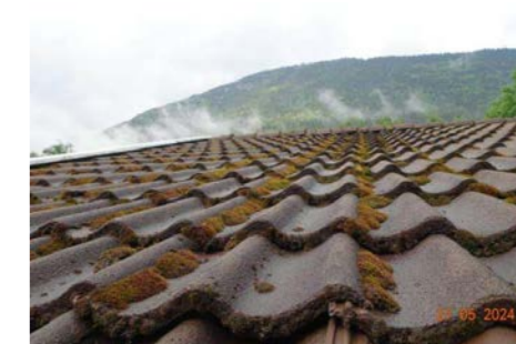
Taktekking av taksteiner.
