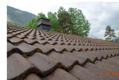
Taktekking av taksteiner.
