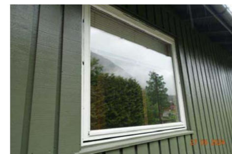
H-vinduer med 3-lags glass.
