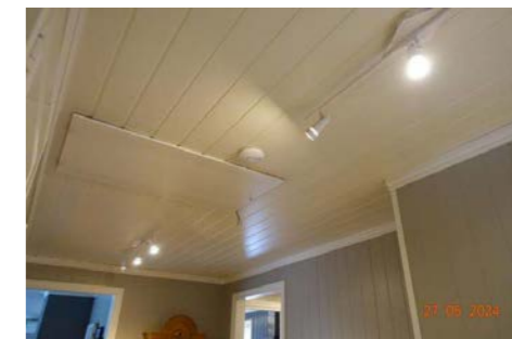
Røykvarsler montert i takhimling.
