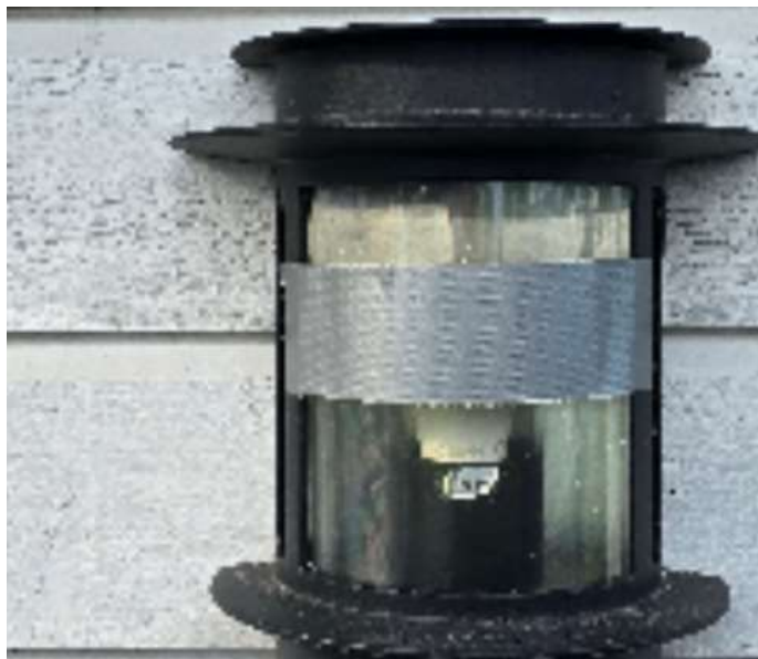
Bilde 1 Lampeskjerm har en tape på skjerm som dekker pære.
