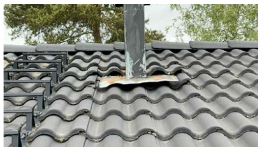
Beslag må tilpasses bedre for å hindre vanninntrenging.
