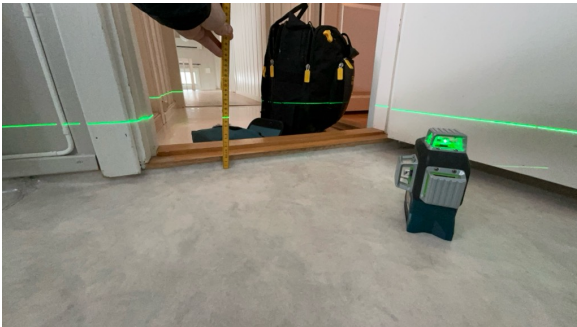
Kontroll fra dør
