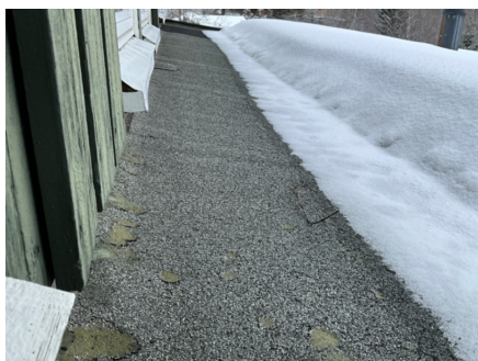
Takpappen sett fra vindu i 2 etasje
