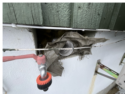
Bilde av åpen kjellermur rundt utkastet fra teknisk rom
