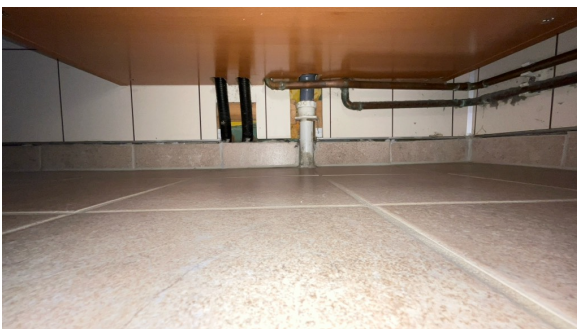
Åpen vegg under servantskap
