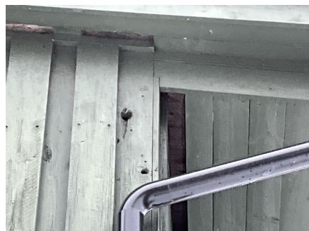
Hull etter hakkespett. Vestvegg
