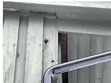
Hull etter hakkespett. Vestvegg
