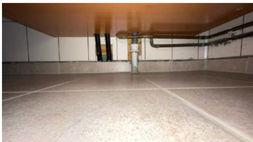
Åpen vegg under servantskap
