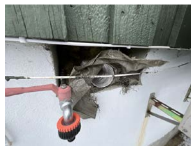
Bilde av åpen kjellermur rundt utkastet fra teknisk rom
