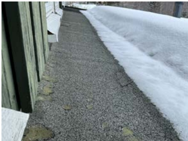
Takpappen sett fra vindu i 2 etasje
