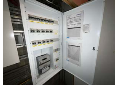
Sikringsskap sokkel
