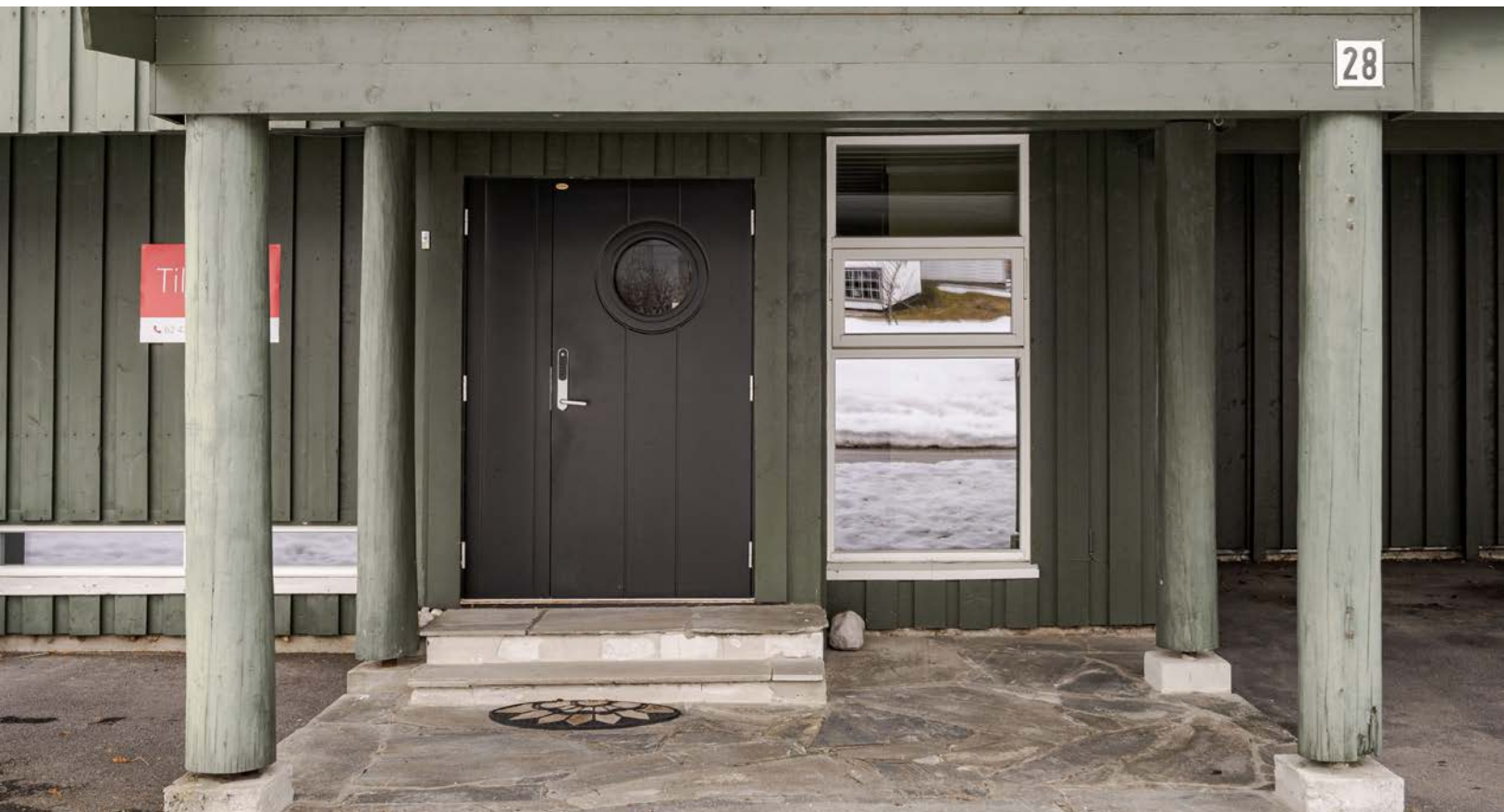
Inngangspartiet har en solid ytterdør fra 2017 og stående kledning som gir et robust utseende.
