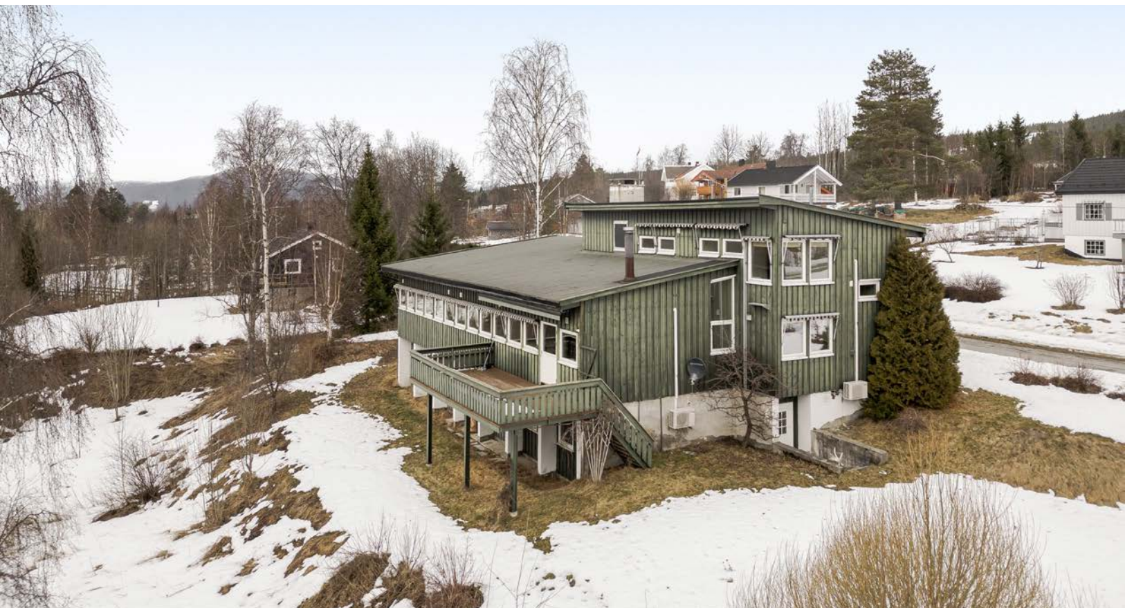
Verandaen har stående kledning med malt håndrekke, og det er trapp fra terreng med rekkverk.
