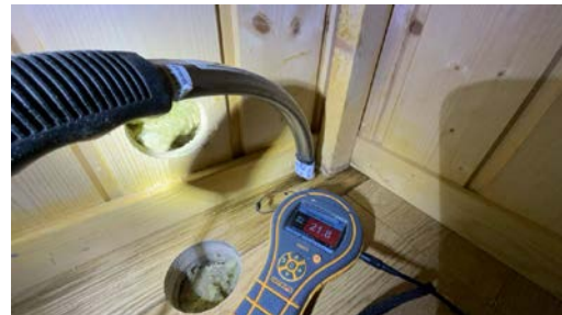
Fuktmåling på gulvoverflate
