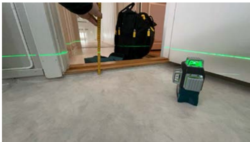
Kontroll fra dør
