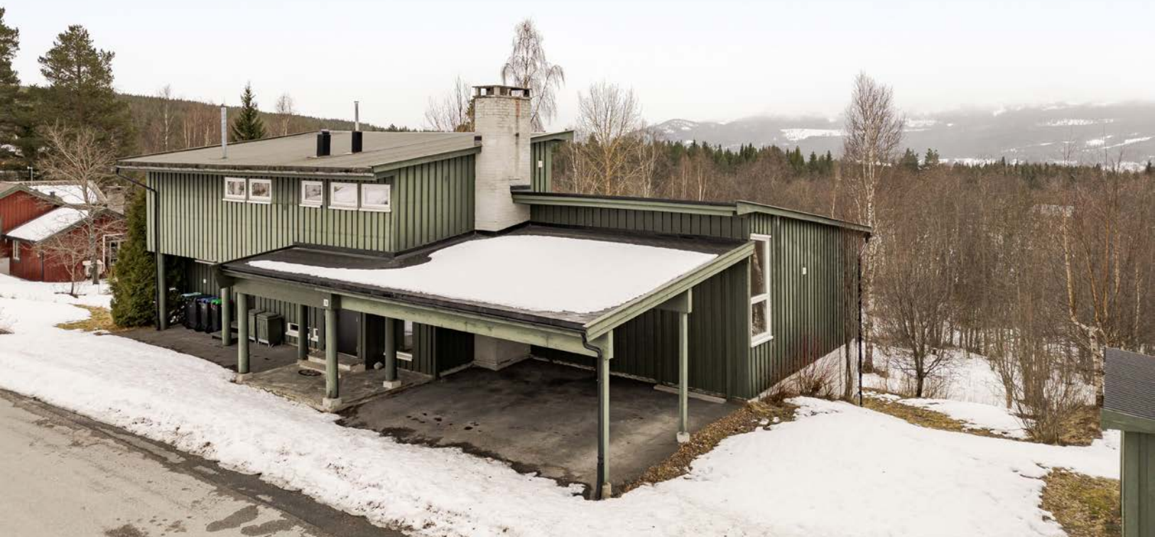
Carport med asfaltert dekke og plass til 2 biler.
