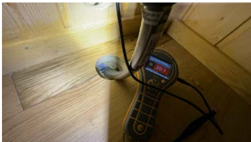
Fuktmåling i tilfarergulv
