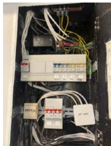
Sikringsskap med automatsikringer.
