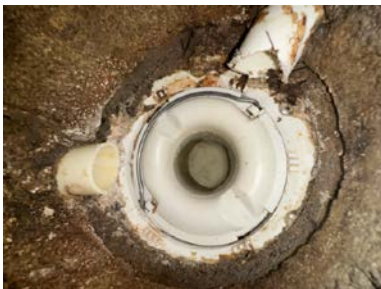
Sluk i plast, plassert i dusjnise
