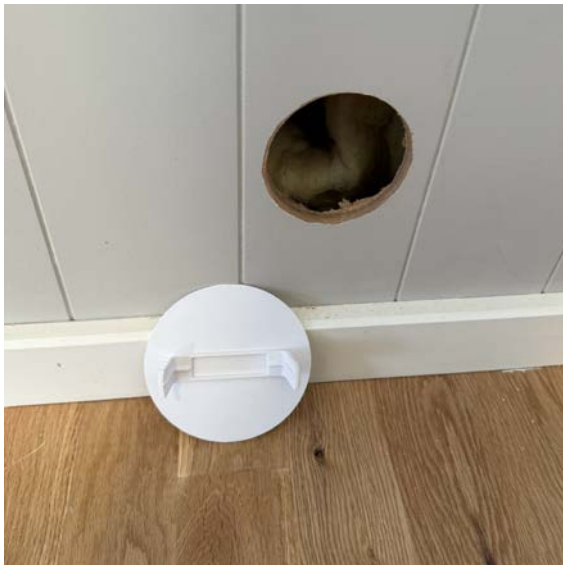
Hulltaking utført bak dusjsone i fra soverom. Ingen fukt målt.
