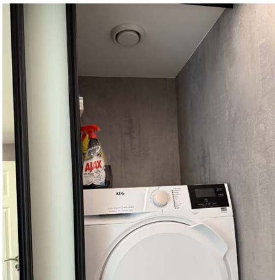
Ventil bak skyvedører på bad.
