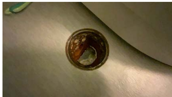
Kontroll av sluk.
