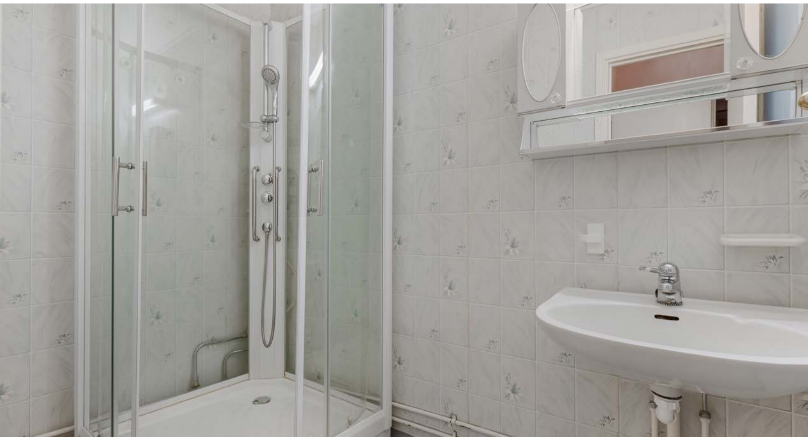
Badet er innredet med servant og dusjkabinett og har originalt tørkeskap for klesvask ol. Badet har våtromstapet på vegger og gulvbelegg på gulv.
