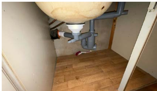
Besiktigelse av rørøpplagg.
