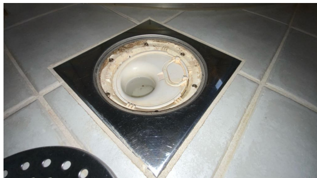
Kontroll av sluk.
