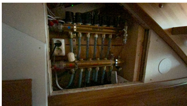
Besiktigelse av røropplegg.
