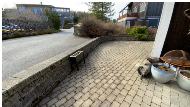
Besiktigelse av støttemur.
