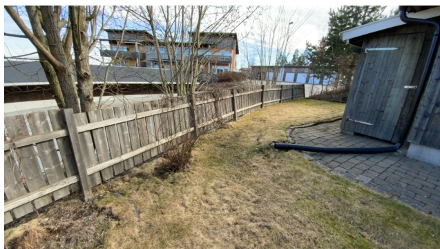
Besiktigelse av gjerder.
