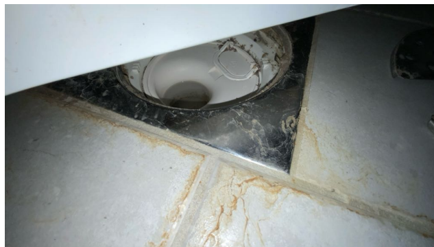
Kontroll av sluk.
