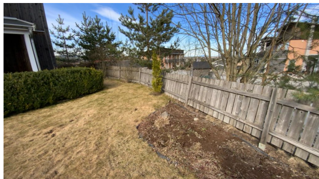
Besiktigelse av gjerder.
