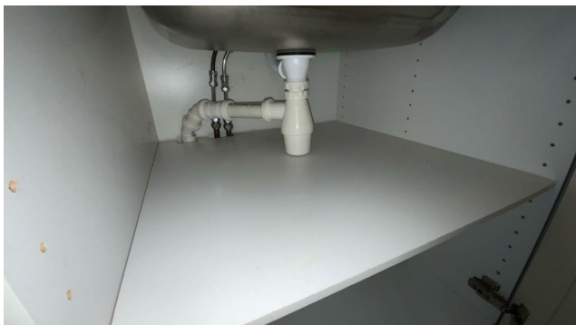
Besiktigelse av røropplegg.
