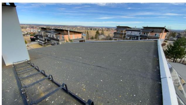
Besiktigelse av taktekke.
