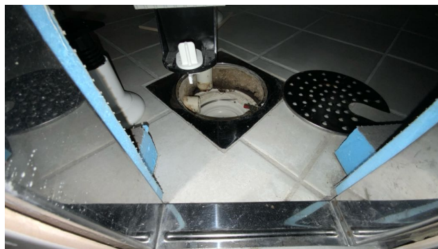
Kontroll av sluk.
