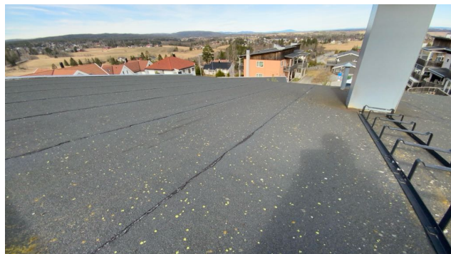
Besiktigelse av taktekke.
