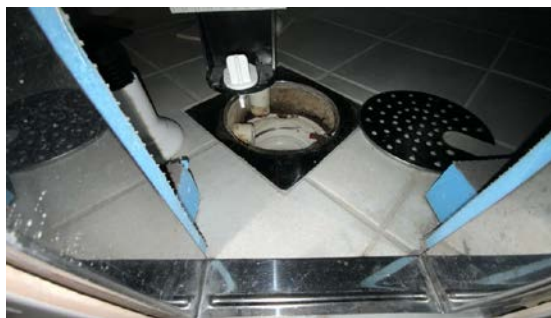
Kontroll av sluk.
