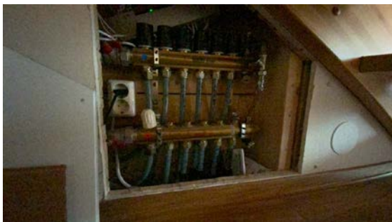
Besiktigelse av røropplegg.
