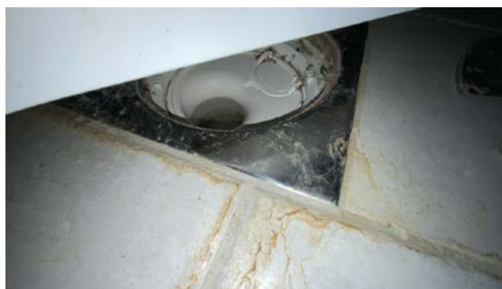
Kontroll av sluk.
