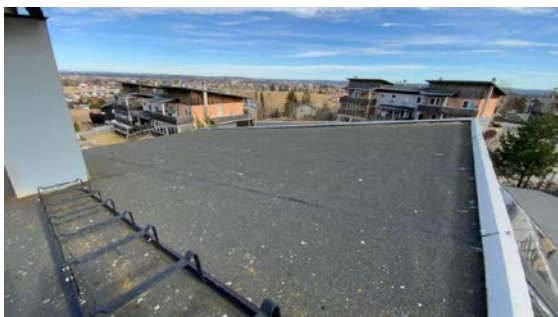
Besiktigelse av taktekke.
