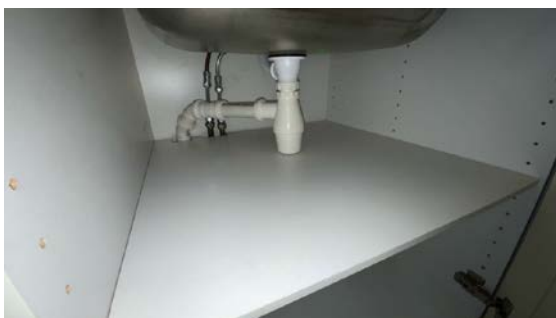
Besiktigelse av røropplegg.
