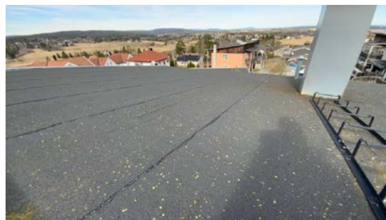
Besiktigelse av taktekke.
