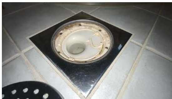
Kontroll av sluk.
