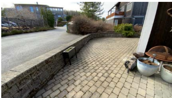
Besiktigelse av støttemur.
