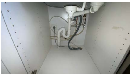
Besiktigelse av røropplegg.
