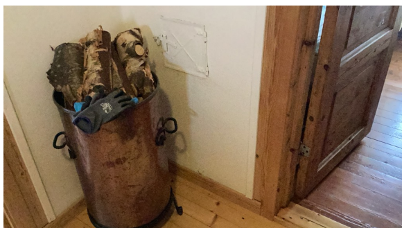
Sotluke i gang.
