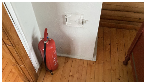
Sotluke på soverom.
