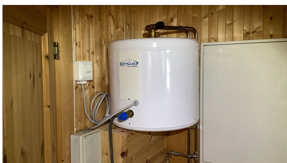
Varmtvannsbereder på bad.
