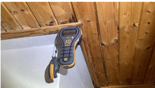
Ved enkel fuktmåling målte jeg tørre verdier.
