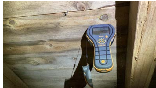
Ved enkel fuktmåling registrerte jeg tørre verdier.
