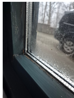
Innvendig tegn til kondensering.
