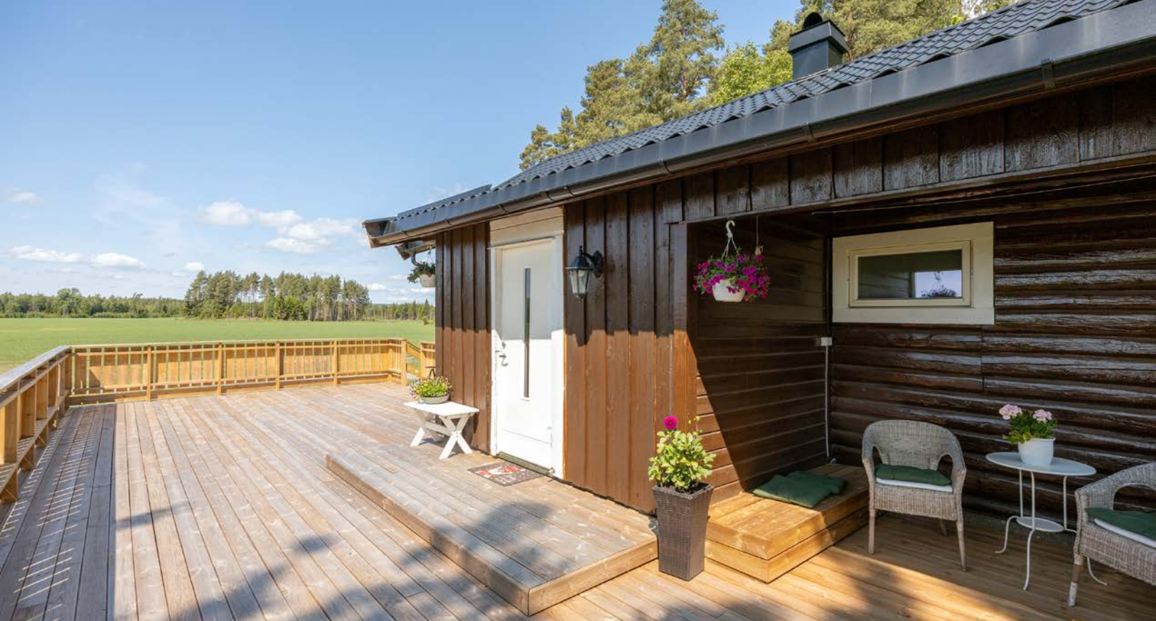
Inngangspartiet ligger i forbindelse med den store terrassen.
