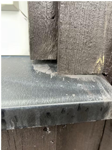
Panel ned til beslag under vindu.
