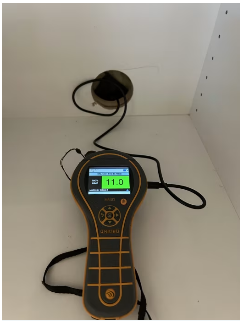
Hulltaking i tilstøtende rom.
