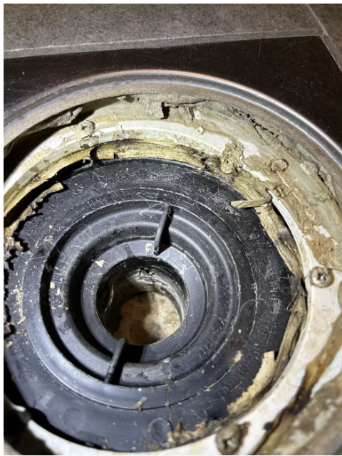
Ingen membran under klemring.
