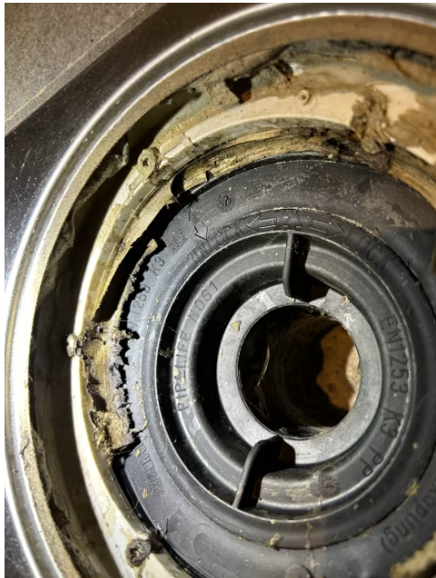
Ingen membran under klemring.
