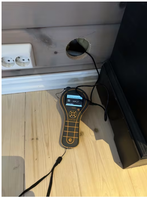
Hulltaking i tilstøtende rom.
