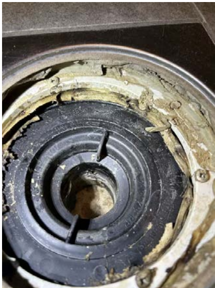
Ingen membran under klemring.
