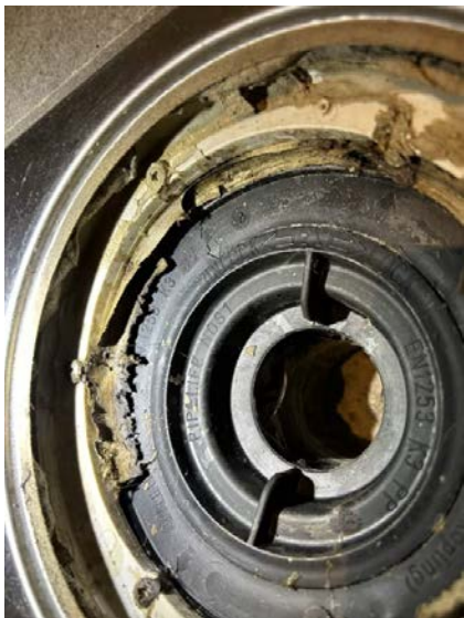
Ingen membran under klemring.
