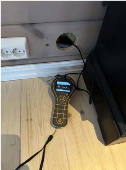
Hulltaking i tilstøtende rom.
