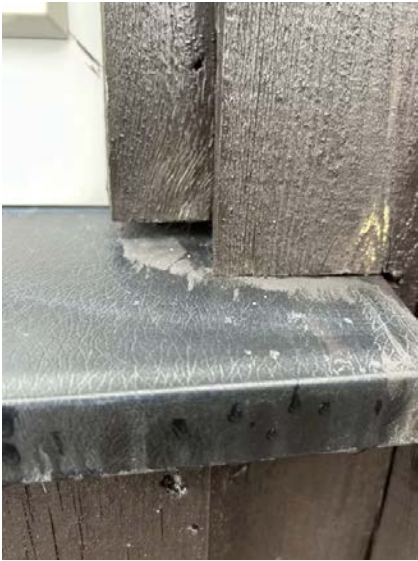
Panel ned til beslag under vindu.
