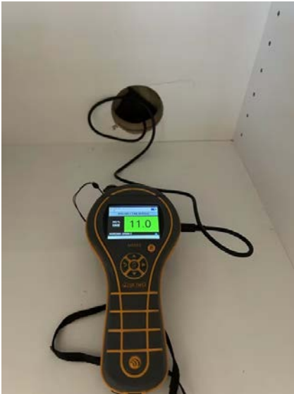
Hulltaking i tilstøtende rom.
