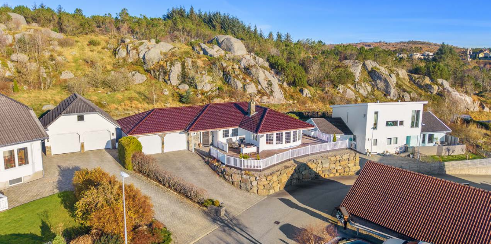
I gårdsrommet er det belegningsstein som leder opp til dobbel garasje.
