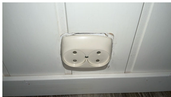
For stort hull i platen rundt stikkontakt
