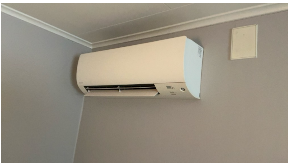
Luft til luft varmepumpe
