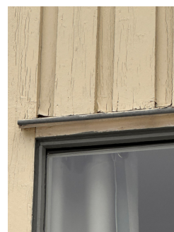
Lite klaring mellom kledning og dekke
