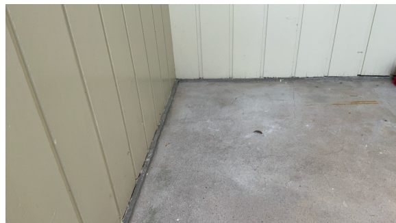
Lite klaring mellom kledning og dekke
