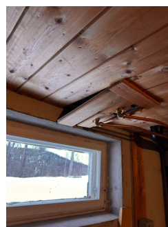
For stort hull i platen rundt stikkontakt
