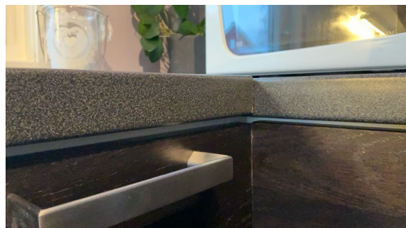
Høydeforskjell på benkeplaten
