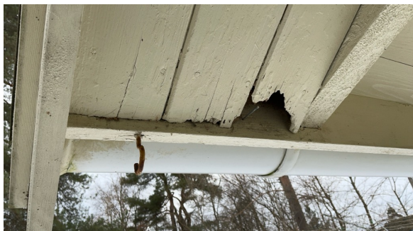
Råte i underkledning
