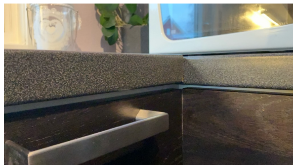
Høydeforskjell på benkeplaten
