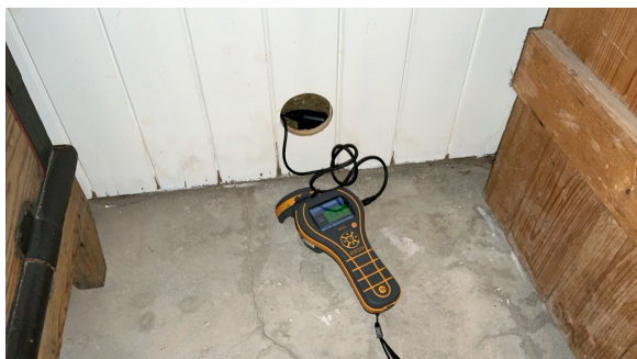
Ingen fuktutslag registret ved fuktmåling i vegg
