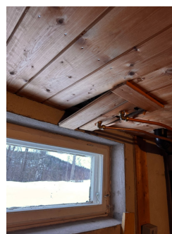
For stort hull i platen rundt stikkontakt
