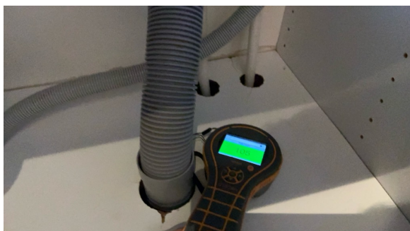
Ingen fuktighet registrert ved fuktsøk
