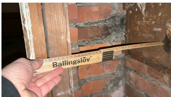
Avstand fra sotluke til brennbart materiale
