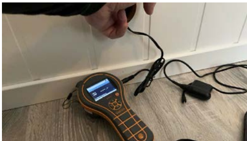
Ingen fuktutslag registret ved fuktmåling i vegg
