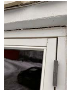
Manglende tetting mellom glass og mur
