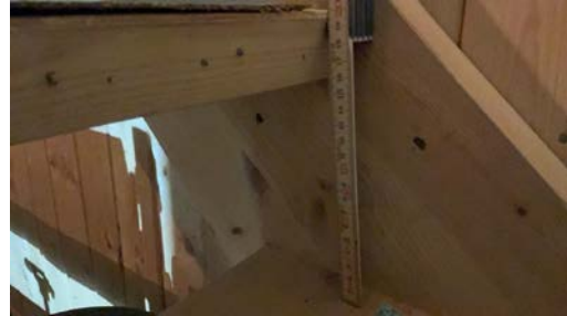
For stor klaring mellom trinnene
