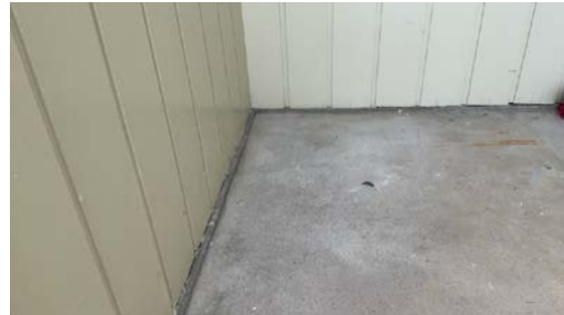
Lite klaring mellom kledning og dekke
