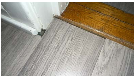
Laminat går ikke under foring
