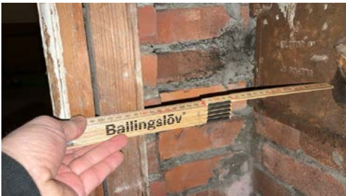
Avstand fra sotluke til brennbart materiale
