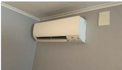
Luft til luft varmepumpe
