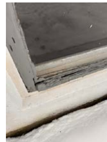
Manglende tetting mellom glass og mur
