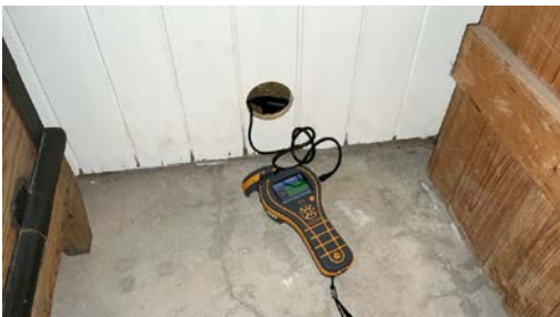
Ingen fuktutslag registrert ved fuktmåling i vegg
