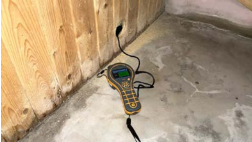
Ingen fuktutslag inni veggen her
