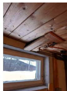
For stort hull i platen rundt stikkontakt
