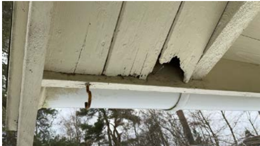
Råte i underkledning
