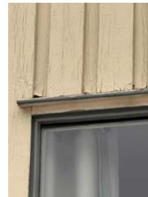
Lite klaring mellom kledning og dekke
