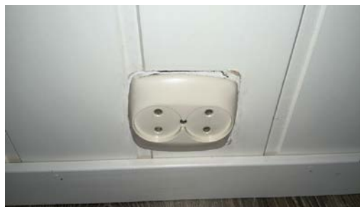
For stort hull i platen rundt stikkontakt
