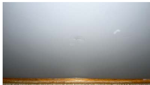
Innpresning/hull i dør
