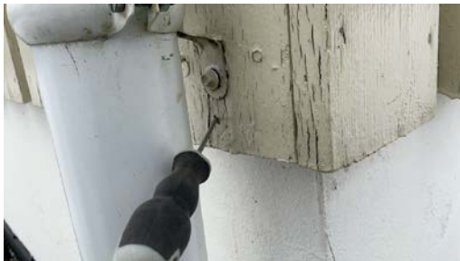
Råte i underkledning
