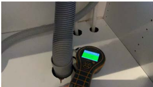
Ingen fuktighet registrert ved fuktsøk
