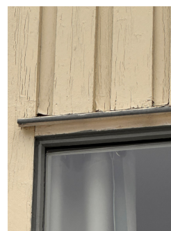
Lite klaring mellom kledning og dekke
