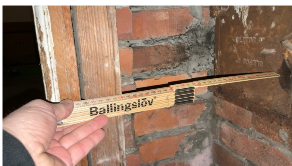
Avstand fra sotluke til brennbart materiale
