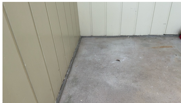
Lite klaring mellom kledning og dekke
