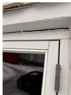
Manglende tetting mellom glass og mur
