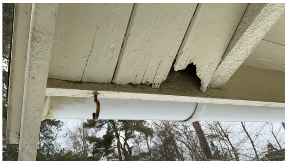
Råte i underkledning
