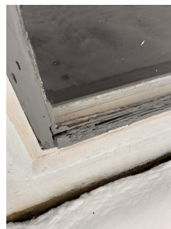
Manglende tetting mellom glass og mur
