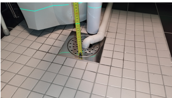
Kontroll av fall.
