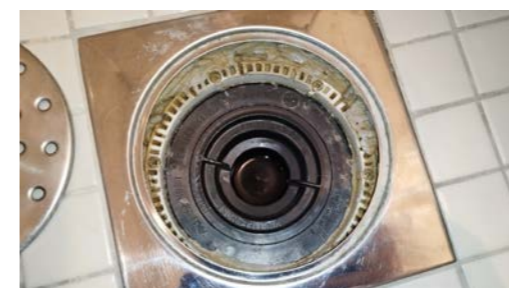
Kontroll av sluk.
