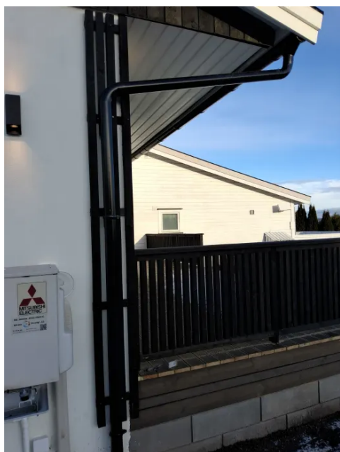
Boligen har takrenner og nedløpsrør i metall.
