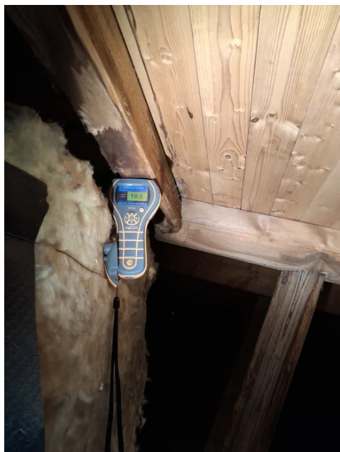
Bilde fra fuktmåling i takkonstruksjon ved pipe.
