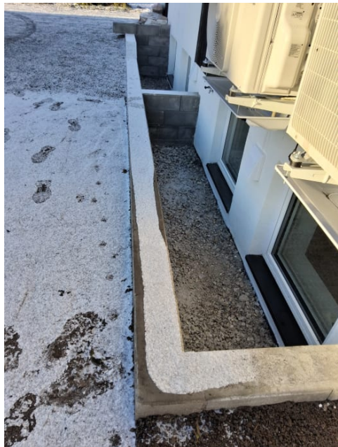
Det er etablert støttemurer/lyskasser ved kjellervinduer.
