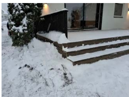
Terreng er justert slik at det ikke er krav om rekkverk, høyde fra gulv til terreng er målt til ca 45 cm.
