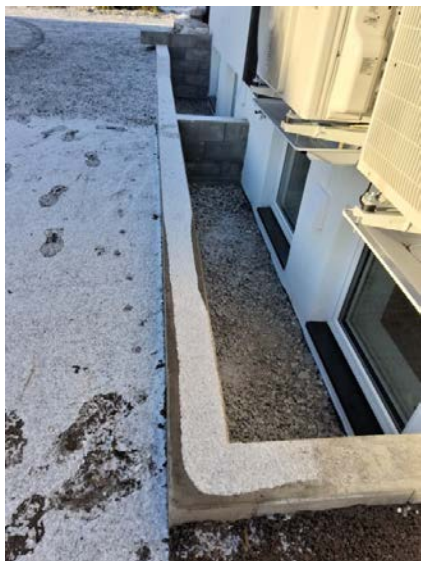
Det er etablert støttemurer/lyskasser ved kjellervinduer.
