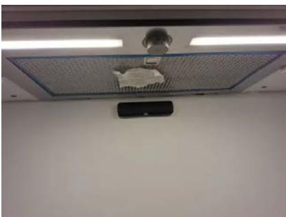
Avtrekkseffekten er testet med papir.
