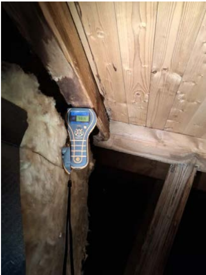
Bilde fra fuktmåling i takkonstruksjon ved pipe.
