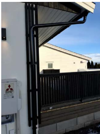
Boligen har takrenner og nedløpsrør i metall.
