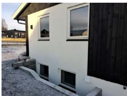
Boligen har vinduer med tre-lags glass.
