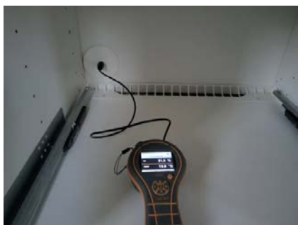
Bilde fra fuktmåling i veggkonstruksjon tilstøtende våtrom.
