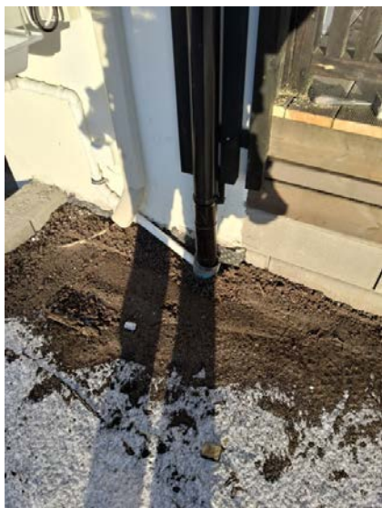
Taknedløp er ledet til drensrør.
