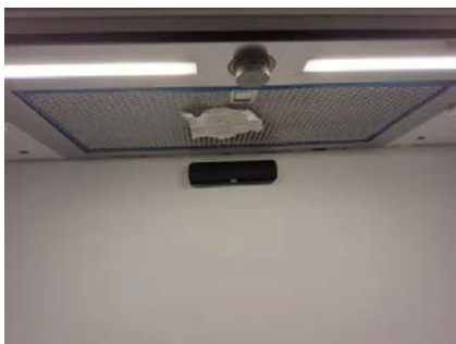
Avtrekkseffekten er testet med papir.
