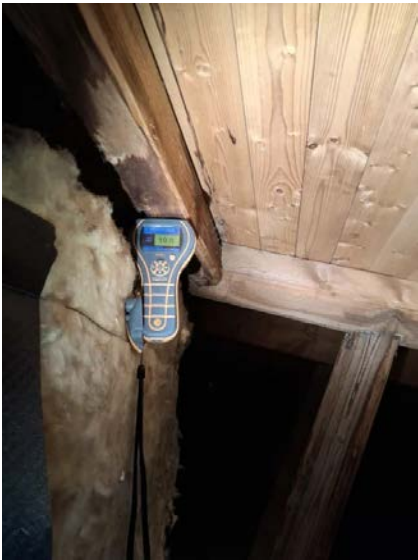
Bilde fra fuktmåling i takkonstruksjon ved pipe.
