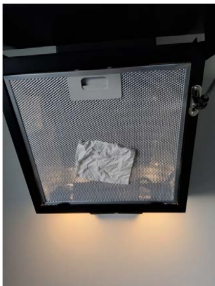
Avtrekkseffekten er testet med papir.
