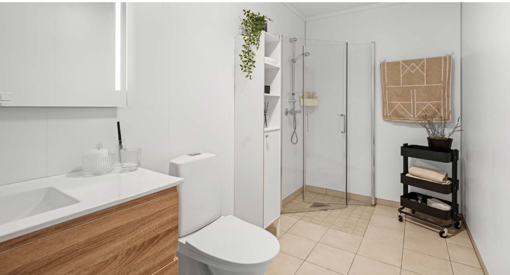
Bad med fliser på gulv og gulvvarme. Baderomsplater på vegger.
