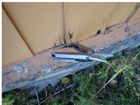
Råteskader i kledning/bunnstokk.
