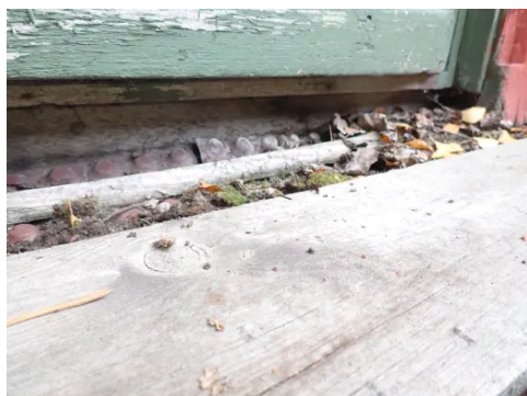
Råteskader i kledning/bunnstokk.
