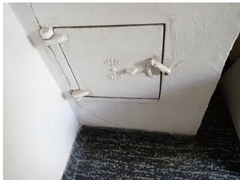
Oversiktsbilde ved sotluke.
