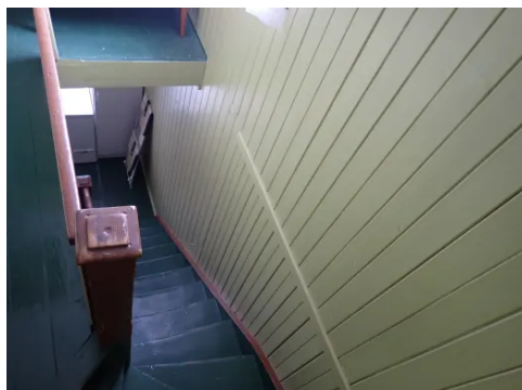
Oversikt ned trapp fra 2. etasje.
