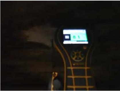
Fuktmåling på kaldloft. Viser at det er tørt ved befaringen.
