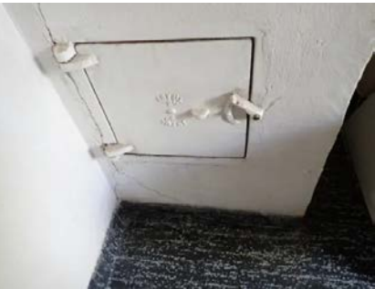
Oversiktsbilde ved sotluke.
