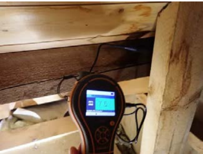
Fuktmåling ved skjolder i loftsrom i 2. etasje. Viser at det er tørt ved befaringen.
