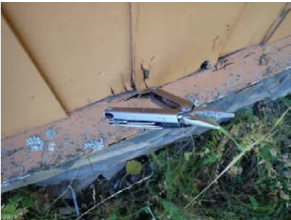
Råteskader i kledning/bunnstokk.
