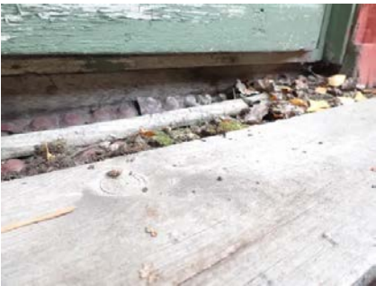
Råteskader i kledning/bunnstokk.
