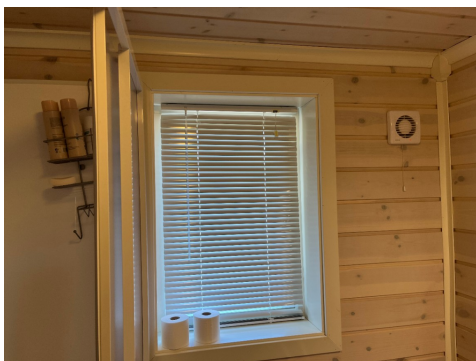
Trepanel og vindu i våtzone til dusj.
