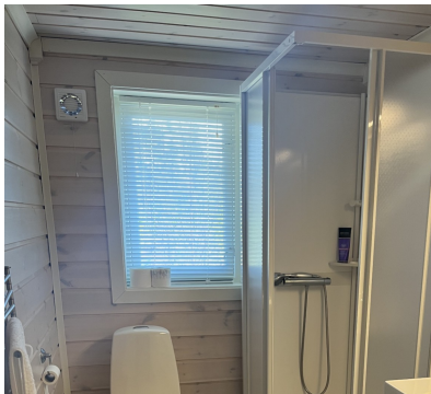
Trepanel og vindu i våtzone til dusj.
