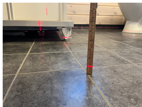
Motfall på ca. 5 mm til midt på gulv.
