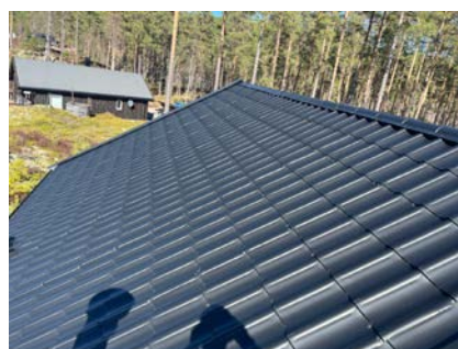
Taktekking av metallplater.
