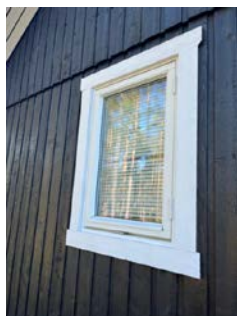
Vindu i gavl er utsatt for nedbør og må ha vannbrett over og under.
