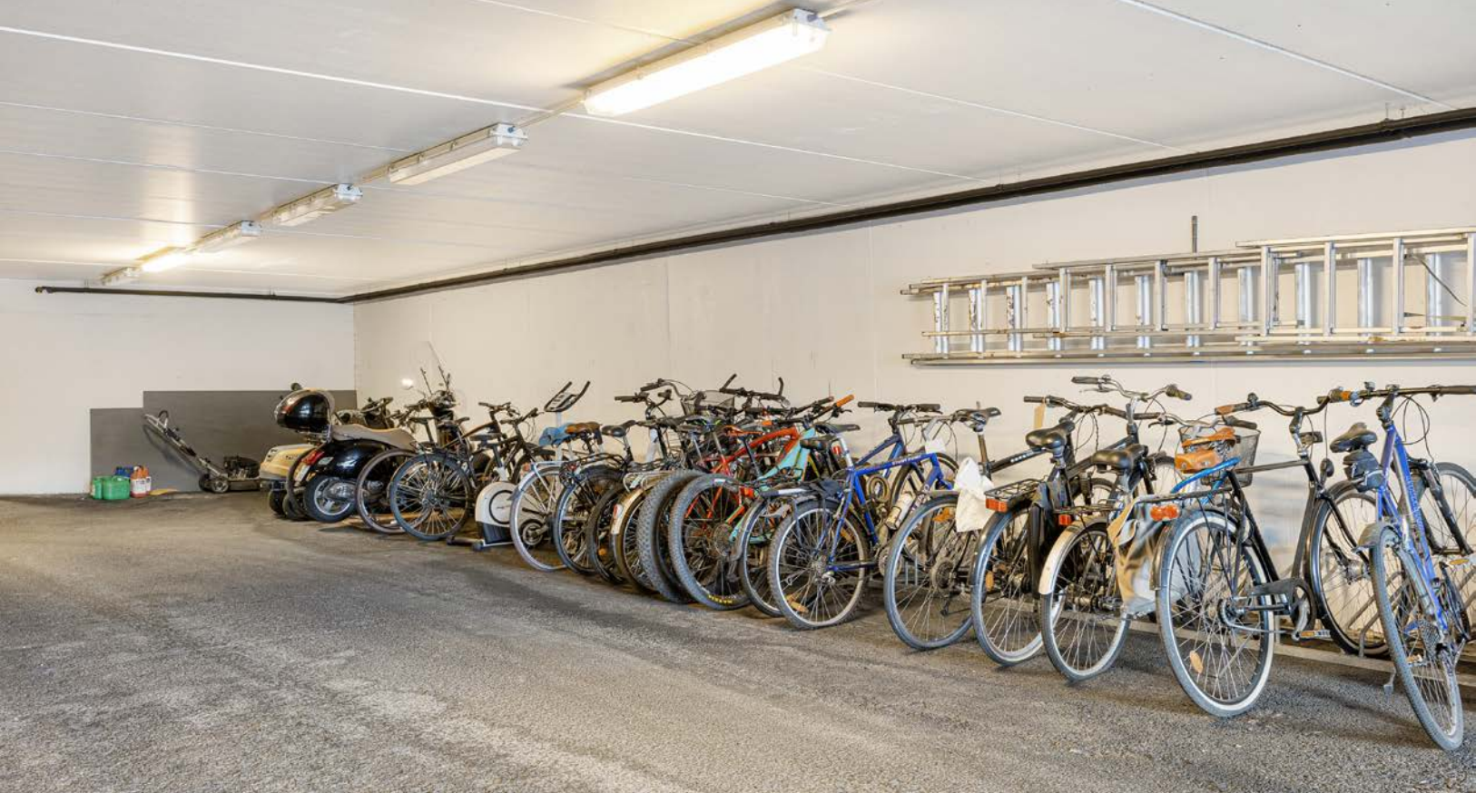
Det er felles sykkelparkering i garasjekjelleren.
