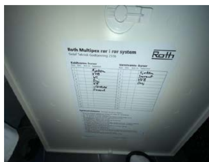
Besiktigelse av rørapplegg.
