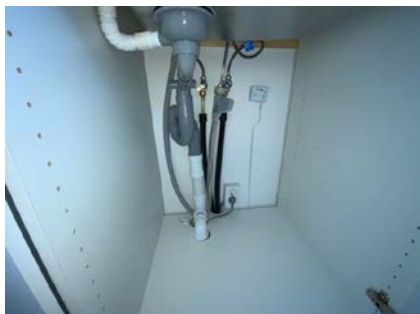
Besiktigelse av rørapplegg.
