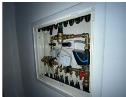
Besiktigelse av rørapplegg.
