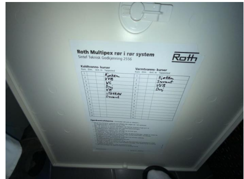
Besiktigelse av røropplegg.
