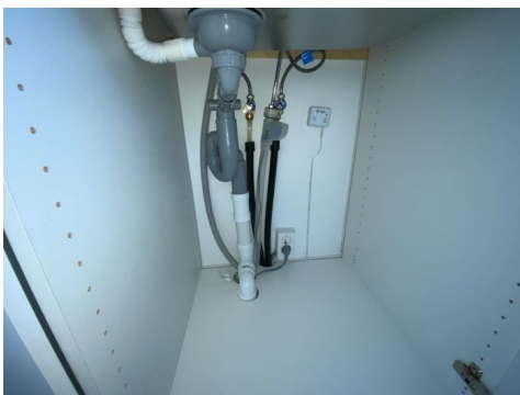
Besiktigelse av røropplegg.
