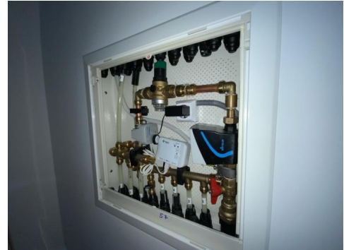
Besiktigelse av røropplegg.
