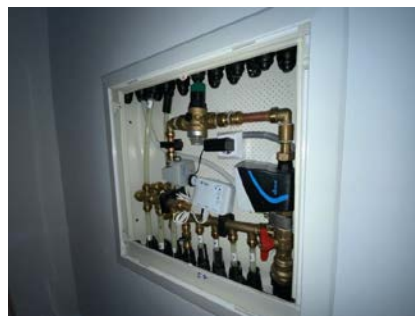
Besiktigelse av røropplegg.
