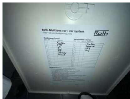
Besiktigelse av røropplegg.
