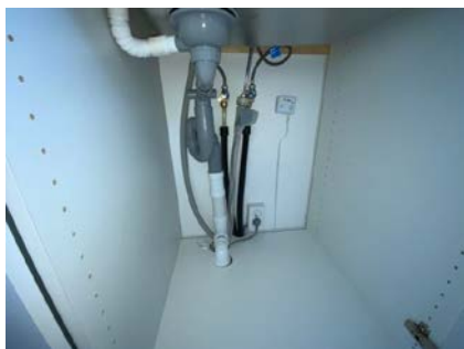
Besiktigelse av røropplegg.
