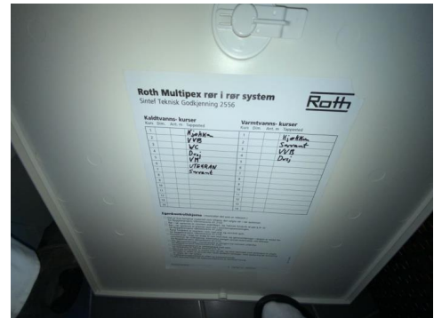
Besiktigelse av røropplegg.
