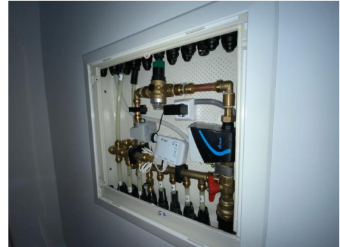
Besiktigelse av røropplegg.
