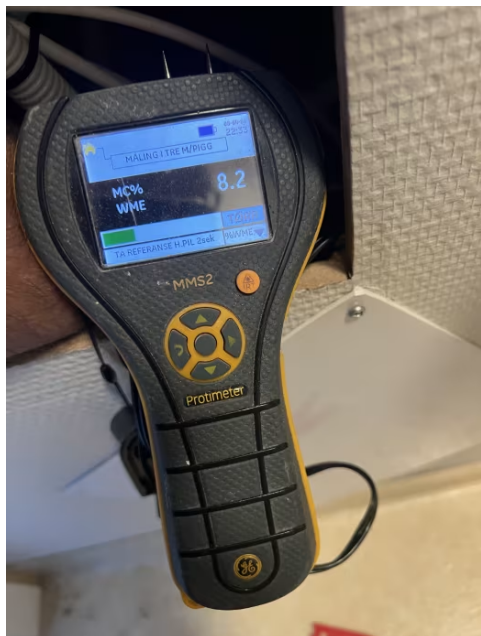
Fuktmåling utført fra eksisterende luke i vegg på vaskerom, målingen er utført i våtsonen. Målingen viser 8.2%, dette er en godkjent verdi.
