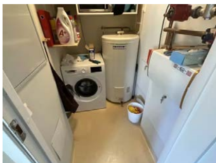
Vaskerom med belegg på gulv og maltestrie på vegg.
