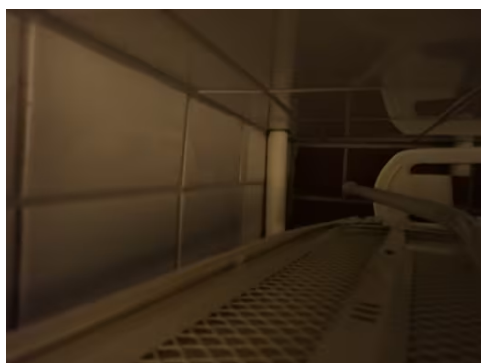
Utførelse av avløp.
