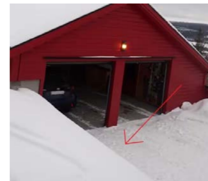
Pil mot gjeldende støttemur
