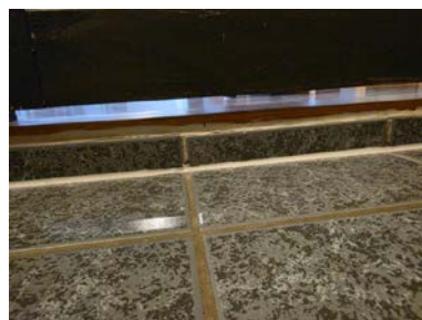
Tilluft under dørblad
