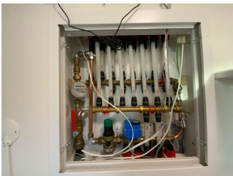
Besiktigelse av røropplegg.
