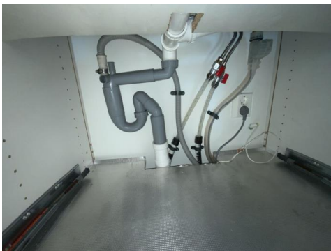
Besiktigelse av røropplegg.
