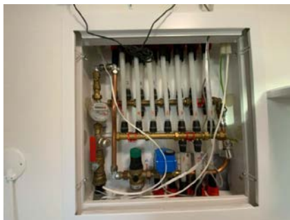
Besiktigelse av røropplegg.
