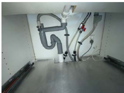
Besiktigelse av røropplegg.
